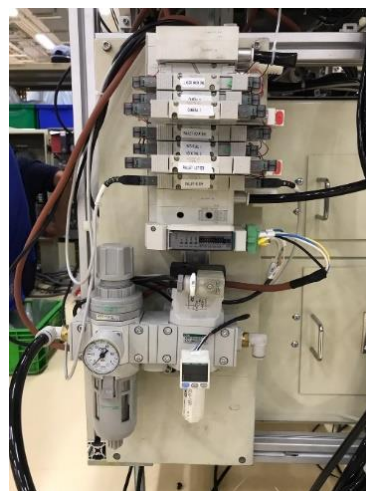
ภาพที่ 8 ขั้นตอนการ Piping Pneumatic
