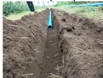
ใช้เครื่องขุดดินขุด
