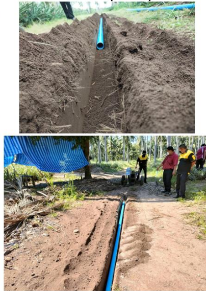
ใช้เครื่องขุดดินขุด
