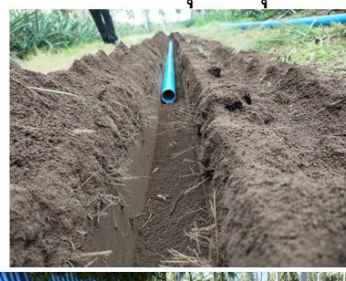
ใช้เครื่องขุดดินขุด
