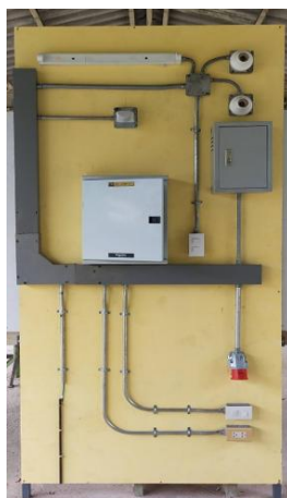
รูปที่ 3 ชุดฝึกทักษะการต่อวงจรการติดตั้งอุปกรณ์ไฟฟ้าในอาคารด้วยท่อโลหะและรางไวร์เวย์ ตามมาตรฐานการติดตั้งไฟฟ้า
