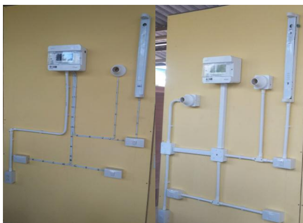
รูปที่ 2 ชุดฝึกทักษะการต่อวงจรการติดตั้งอุปกรณ์ไฟฟ้าในอาคาร ด้วยเข็มขัดรัดสาย และท่อพีวีซี ตามมาตรฐานการติดตั้งไฟฟ้า
