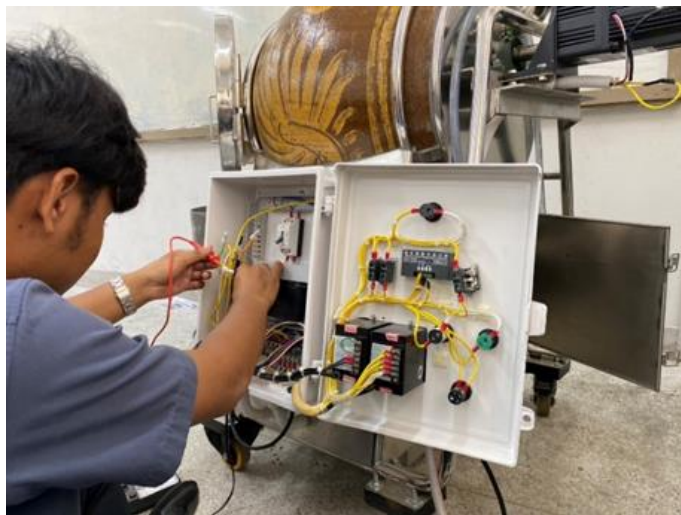
ภาพที่ 4 ติดตั้งระบบควบคุมไฟฟ้าและแก๊ส
